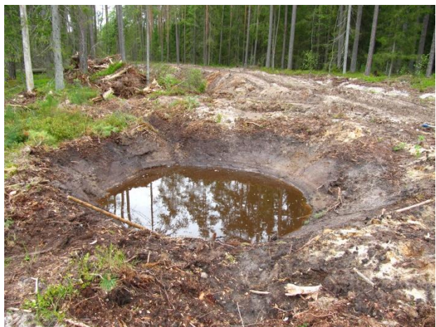
Ebaõnnestunud leevendustiik, mis on liiga väike ning järsunõlvaline (fotod M. Vaikre).
