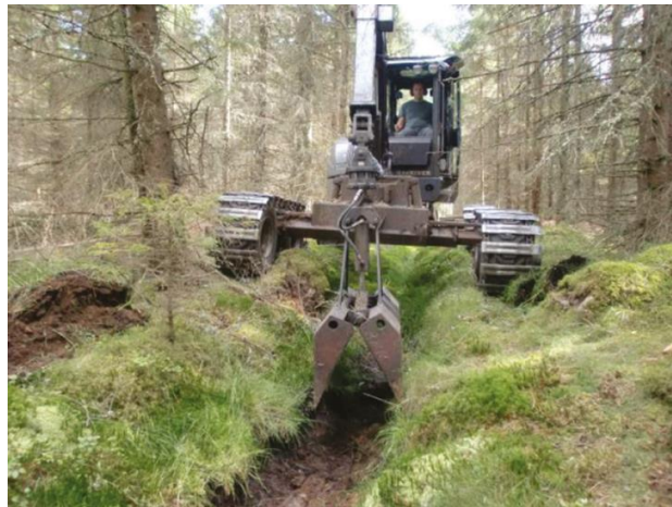
Kraavinõlvade erosiooni saab vähendada puhastades taimestikust vaid kraavipõhjad (Finer jt 2018 10 ).
