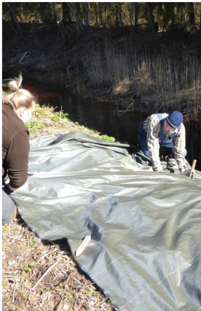
KATMINE GEOTEKSTIILIGA
