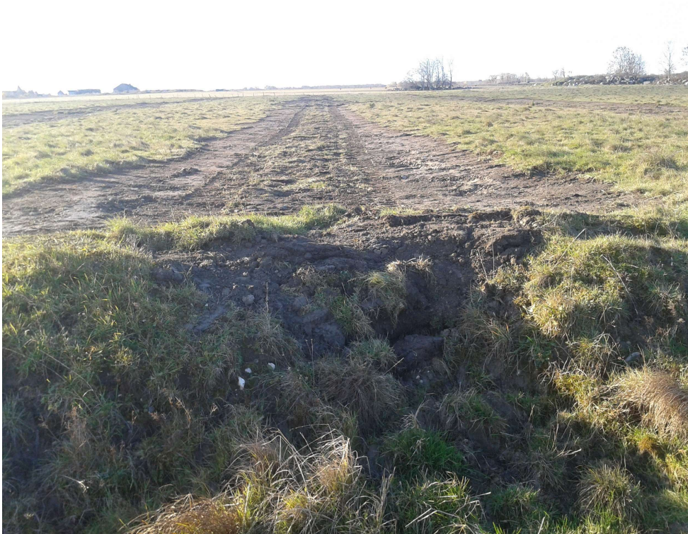
Pärast töid on kitsast ja järsu servaga kraavist kujundatud lai ja madal koht ning kraav on otsast täidetud pinnasest tehtud tammiga, et niidult vett kuivendussüsteemi ära ei voolaks. On loodud tingimused alale ajutiste lompide tekkeks. Foto: Silvia Lotman
