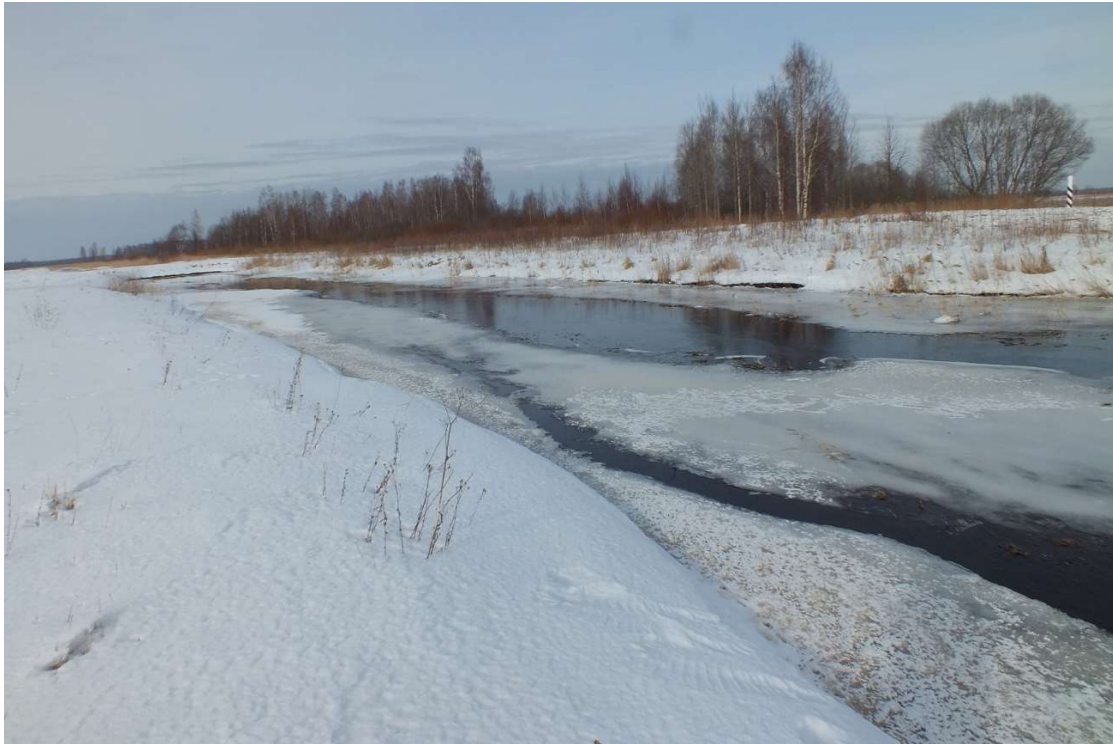
Foto 2. Jaama kanal, vaade sissevoolust allavoolu 8.03.2018.
