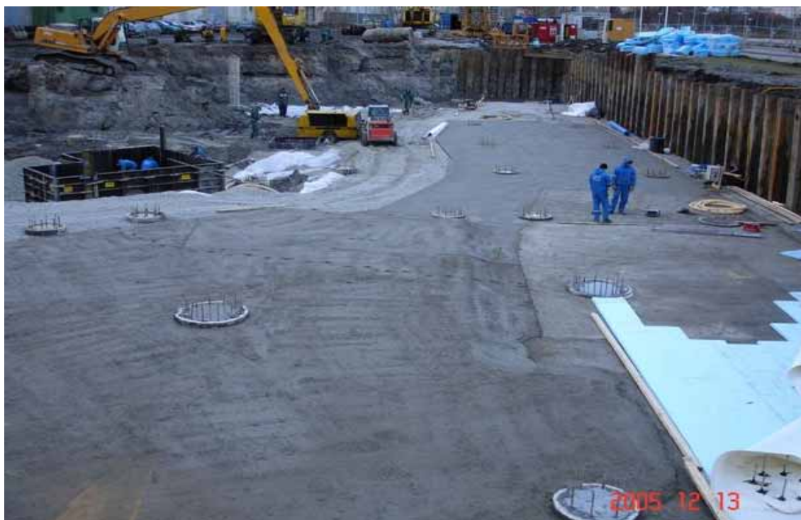
Foto. Hüdroiolsiooni paigaldamine Allikas: OÜ Langeproon Inseneriehitus
