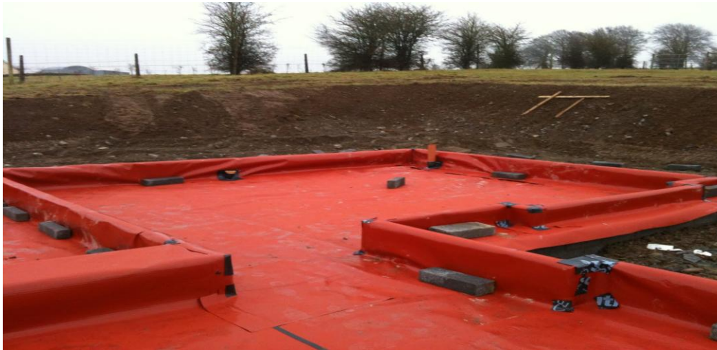
Joonis 6. Radoonitõkkekile paigaldamine ( Radon barrier, 2011 ).
