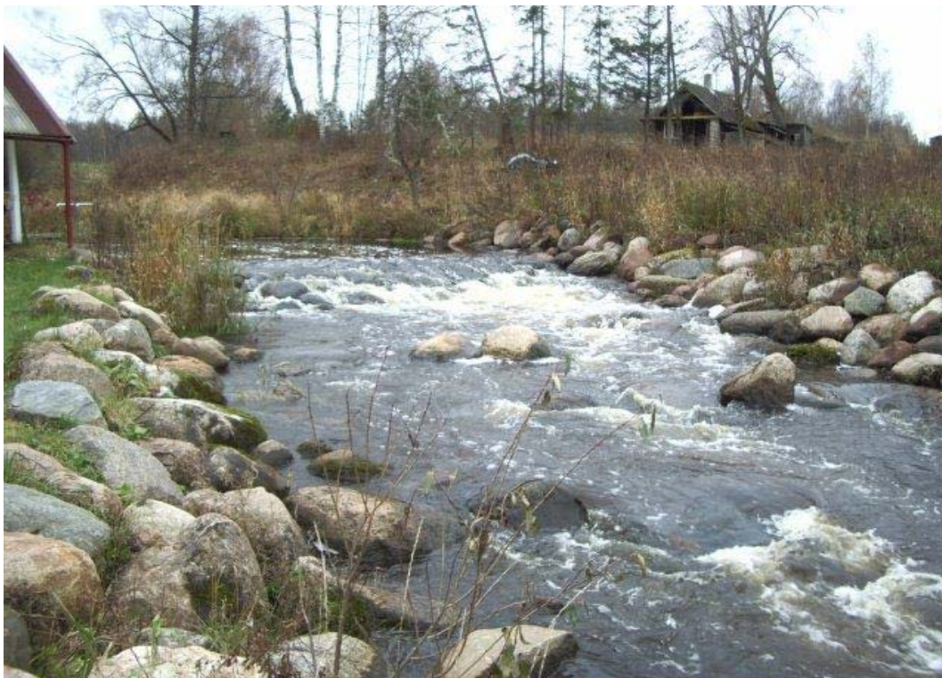
Foto 30. Lalli II kalapääsust allavoolu ehitatud tehiskärestik (31.10.2017).
