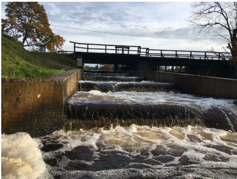
Foto 8. Joaveski kalapääs (17.10.17). Kalapääsu väljavoolu ning jõe veetasemete vahe 0.4 m.
