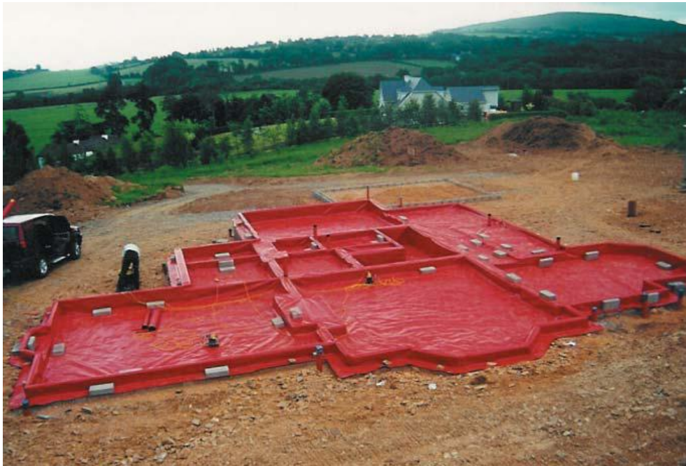
Foto 1. Radoonikile paigaldamine hoone vundamendile (Kilekeskus).
