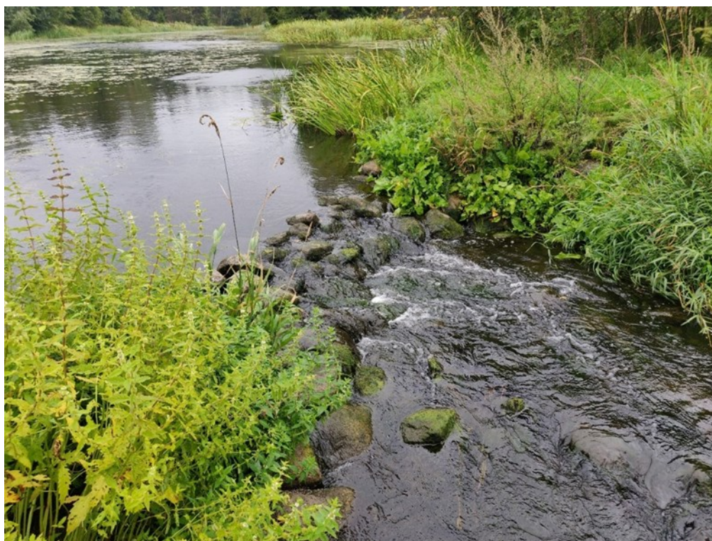
Foto 10. Vaade kalapääsu sissevoolule 18.08.2021.
