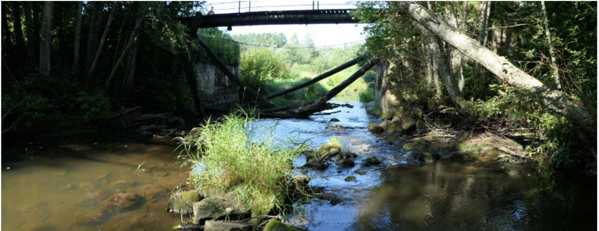
Foto 6. Purtsiveski liigveelaskme ava, vaade allavoolu 16.08.2022
