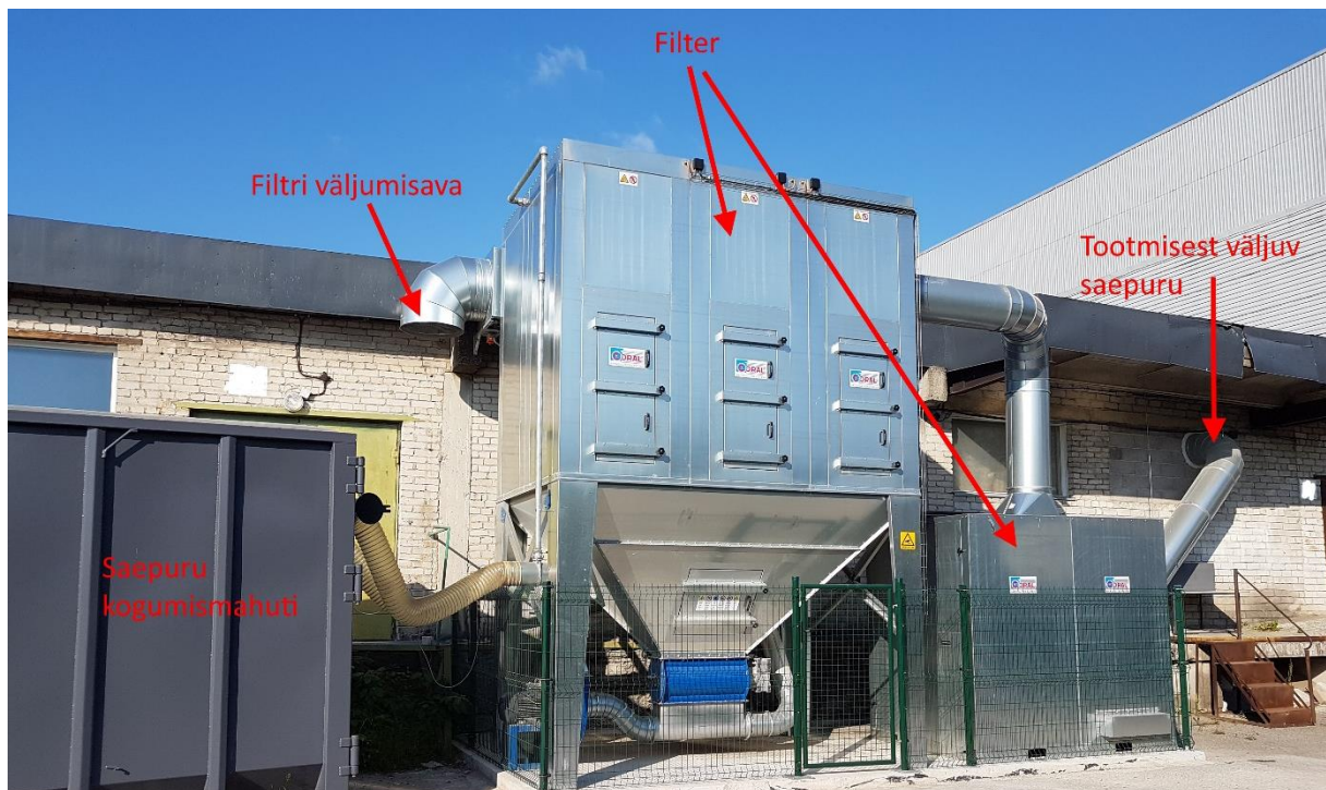
Joonis 1. Filtriga saepuru kogumissüsteem. Filtrist väljuv õhk suunatakse välisõhku.
