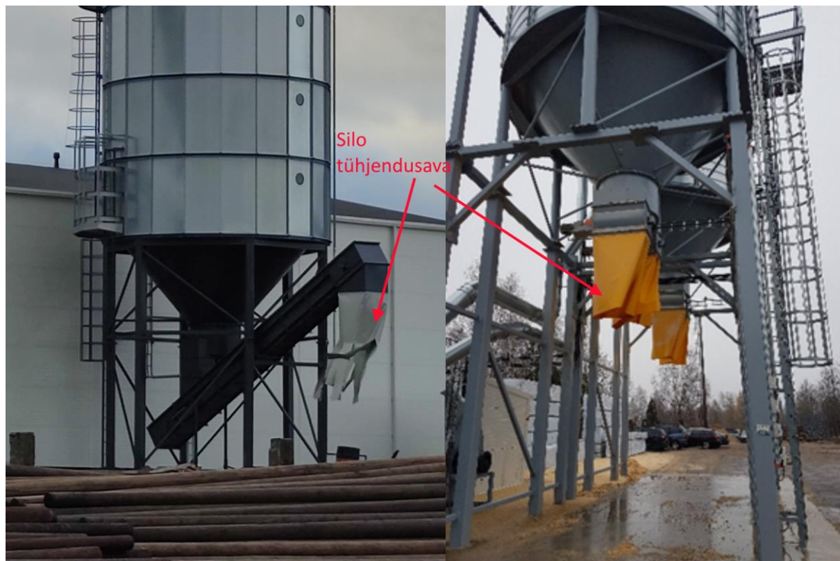
Joonis 6. Silo tühjendusavad erinevatel silodel.
