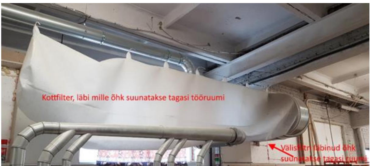
Joonis 2. Saepuru kogumissüsteemi läbinud õhk suunatakse läbi kottfiltri tagasi siseruumi. Otsene heide välisõhku puudub.
