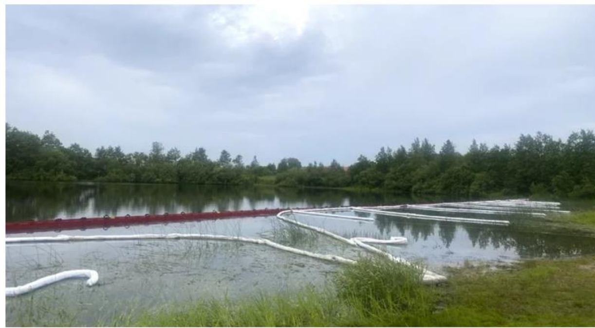
Päästjad paigaldasid järvele õlireostuse piiramiseks 100 meetrit rannikupoomi ning 150 meetrit õli absorbeerivat poomi. Foto: Mariliis Vest
